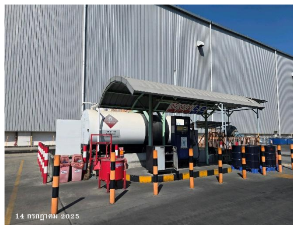
ภาพที่ 2-35 สถานีเติมน้ำมันดีเซลขนาด 20 ลูกบาศก์เมตร
