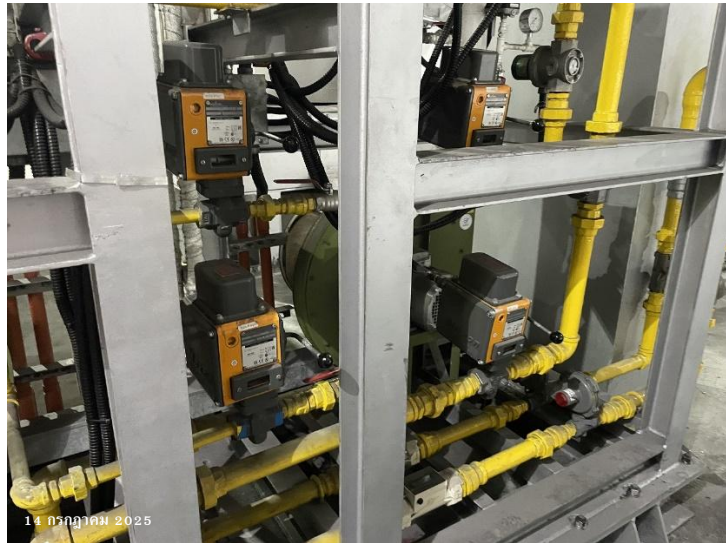
ภาพที่ 2-46 ระบบ Safety Valve เพื่อป้องกันการรั่วไหลของ Flue gas ออกจากระบบ
