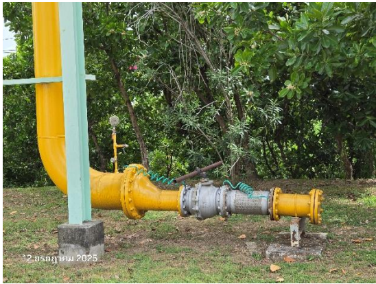
ภาพที่ 2-37 (ต่อ) Insulation Joint/Flang
