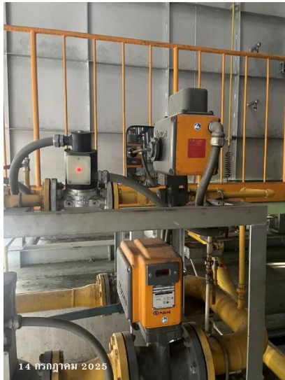
ภาพที่ 2-46 ระบบ Safety Valve เพื่อป้องกันการรั่วไหลของ Flue gas ออกจากระบบ
